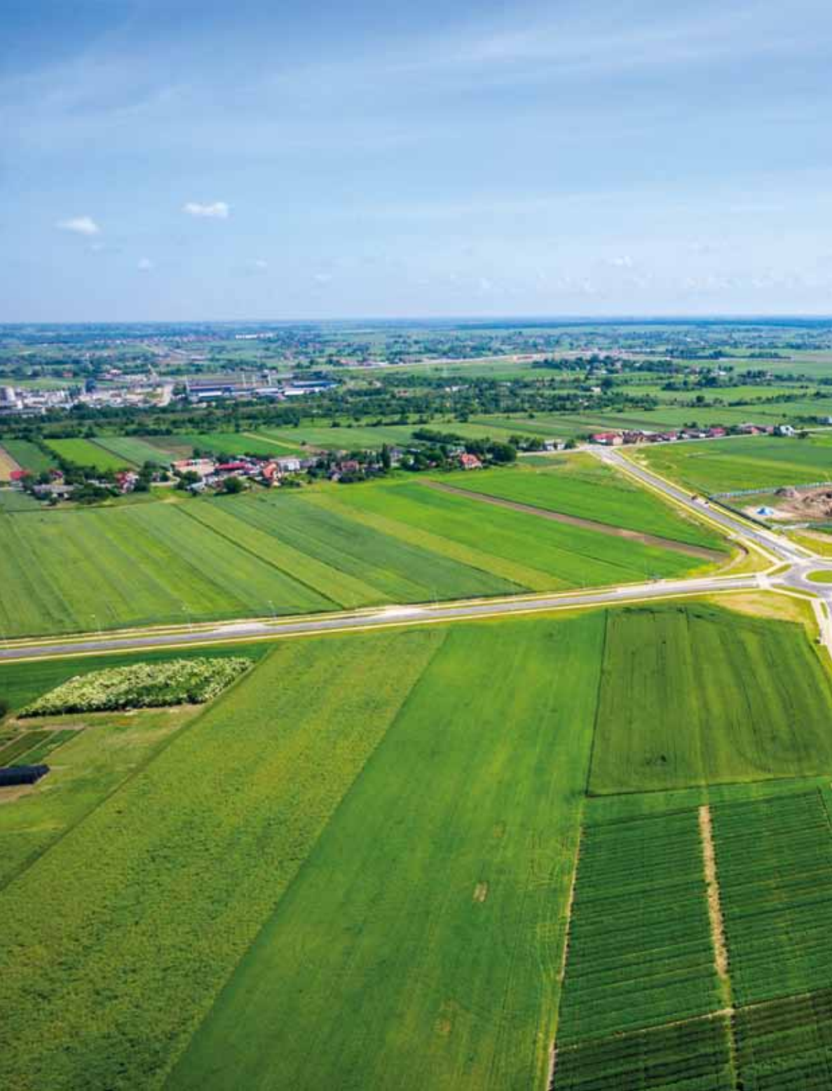
Widok na „nową” część Podstrefy Lublin i plac budowy firmy Medi-Sept z perspektywy ulicy Braci Krausse (2014 r.) | autor: Paweł Gajewski, GIS Support
